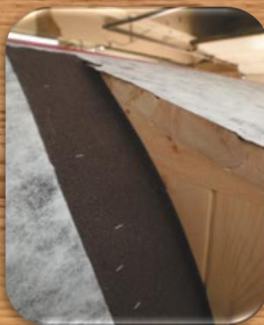
4 ЭТАП. Монтаж ендового ковра
