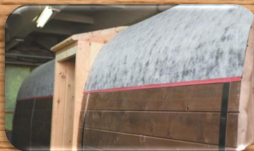
2 ЭТАП. Монтаж подкладочного ковра
