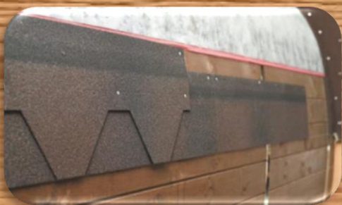
3 ЭТАП. Монтаж коньково-карнизной Черепицы в стартовом ряду
